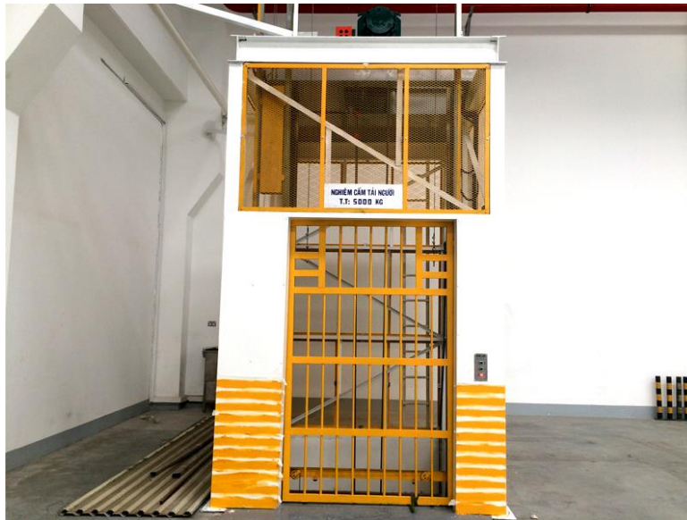
Thang máy tải hàng đơn giản tại các công trường đang thi công
